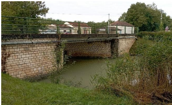
Pont de la D238 sur le Canal de la Seudre à la Charente
