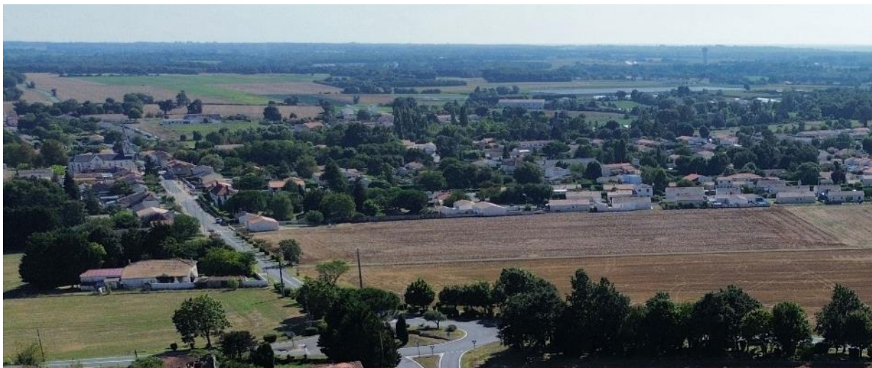
Vue oblique depuis l'entrée nord du bourg : un bourg « vert »
