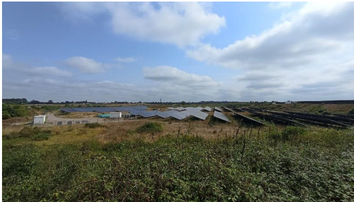
Parc photovoltaïque de Champigny
