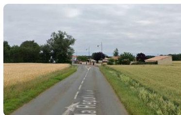
Entrée sud RD117
