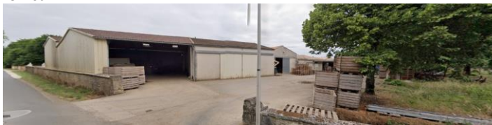
Des bâtiments agricoles
